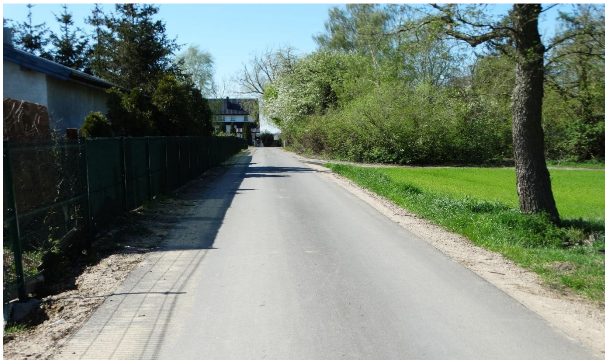
Budowa nowej nawierzchni na ul. Działkowej.
