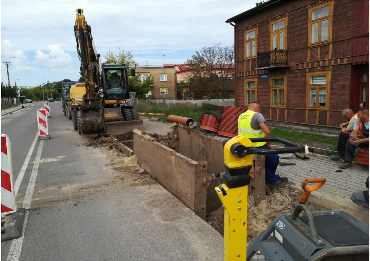
Budowa kanalizacji na ul. Płockiej.
