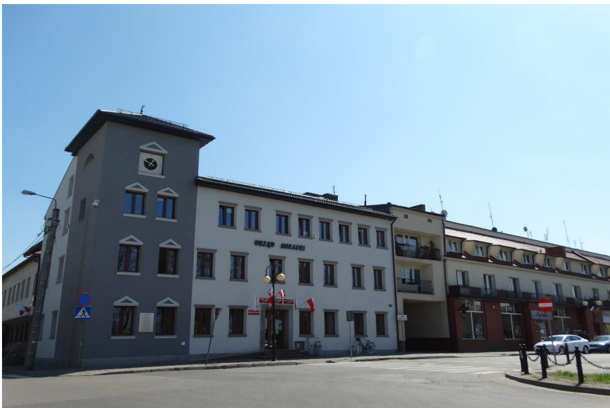
Termomodernizacja budynku Urzędu Miasta.
