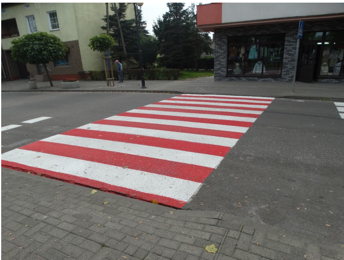
Zmodernizowane przejście dla pieszych na Placu Mickiewicza w centrum miasta.
