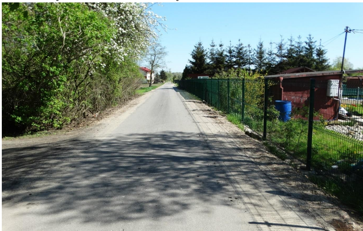
Budowa nowej nawierzchni na ul. Działkowej.
