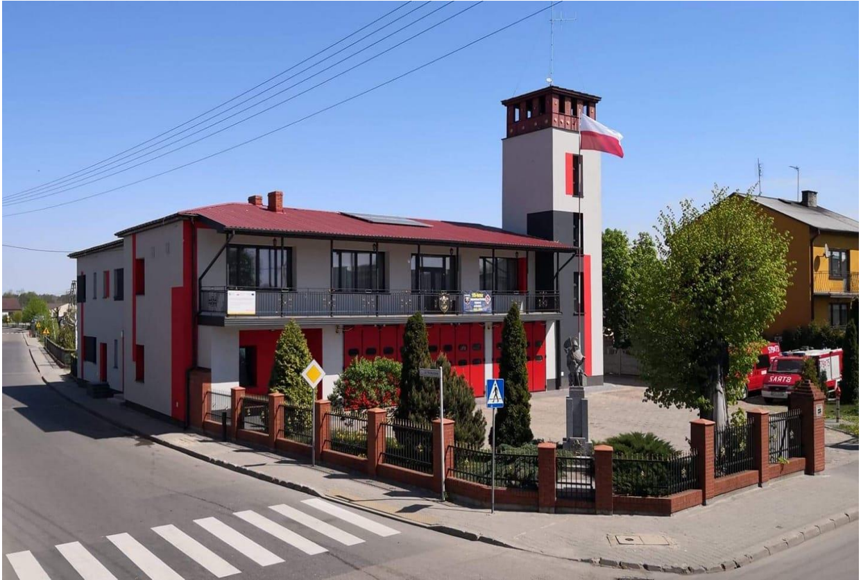
Termomodernizacja budynku ochotniczej straży pożarnej w Raciążu.
