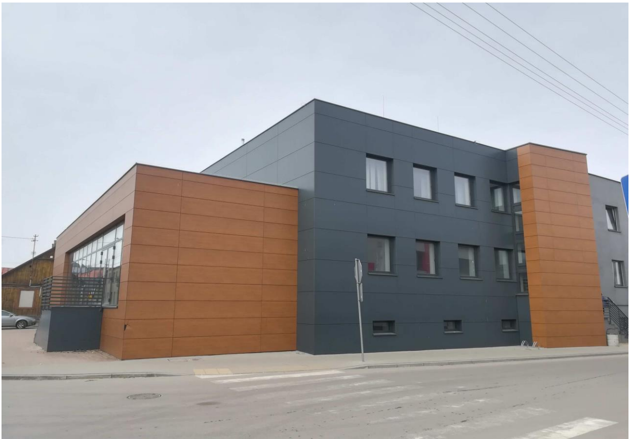
Termomodernizacja Miejskiej Biblioteki Publicznej w Raciążu.
