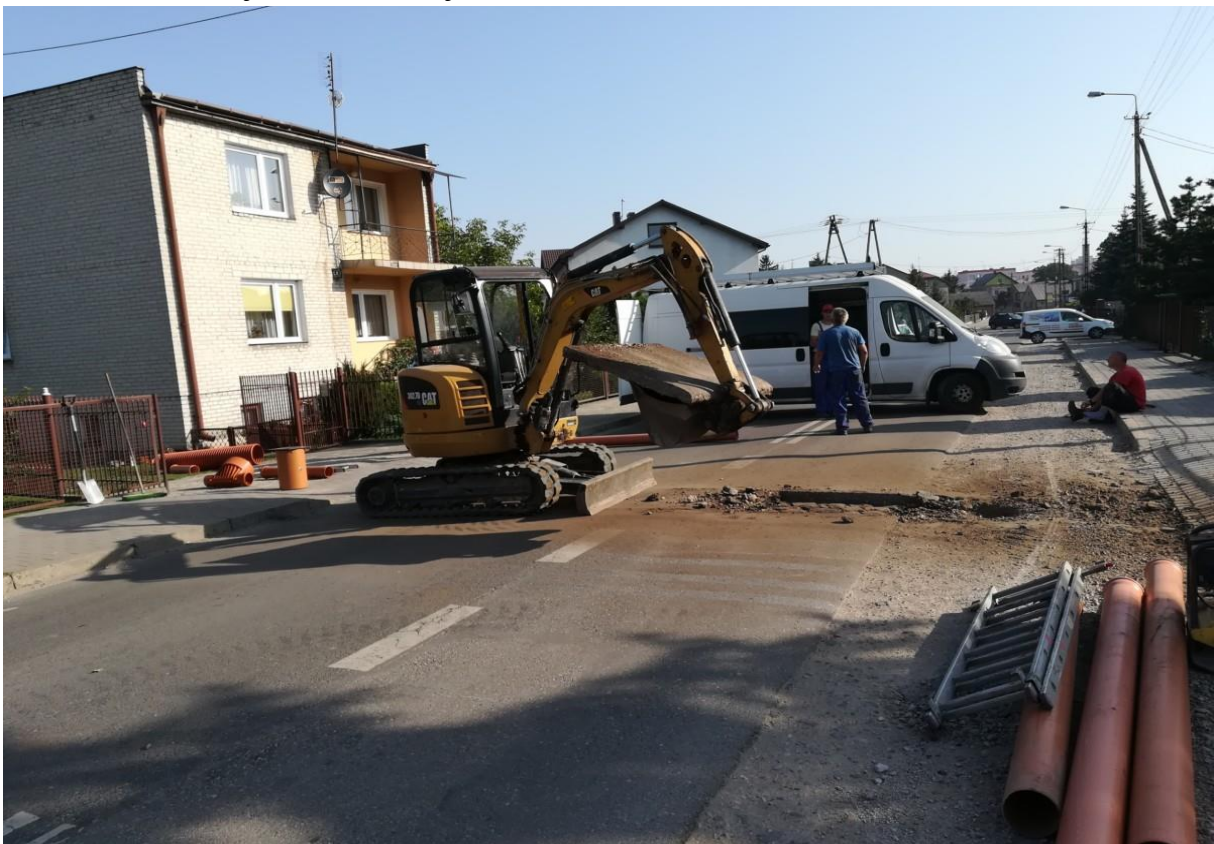
Budowa kanalizacji na ul Płockiej.
