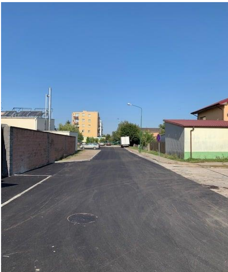
Nowa nawierzchni na ul. Jana Pawła II
