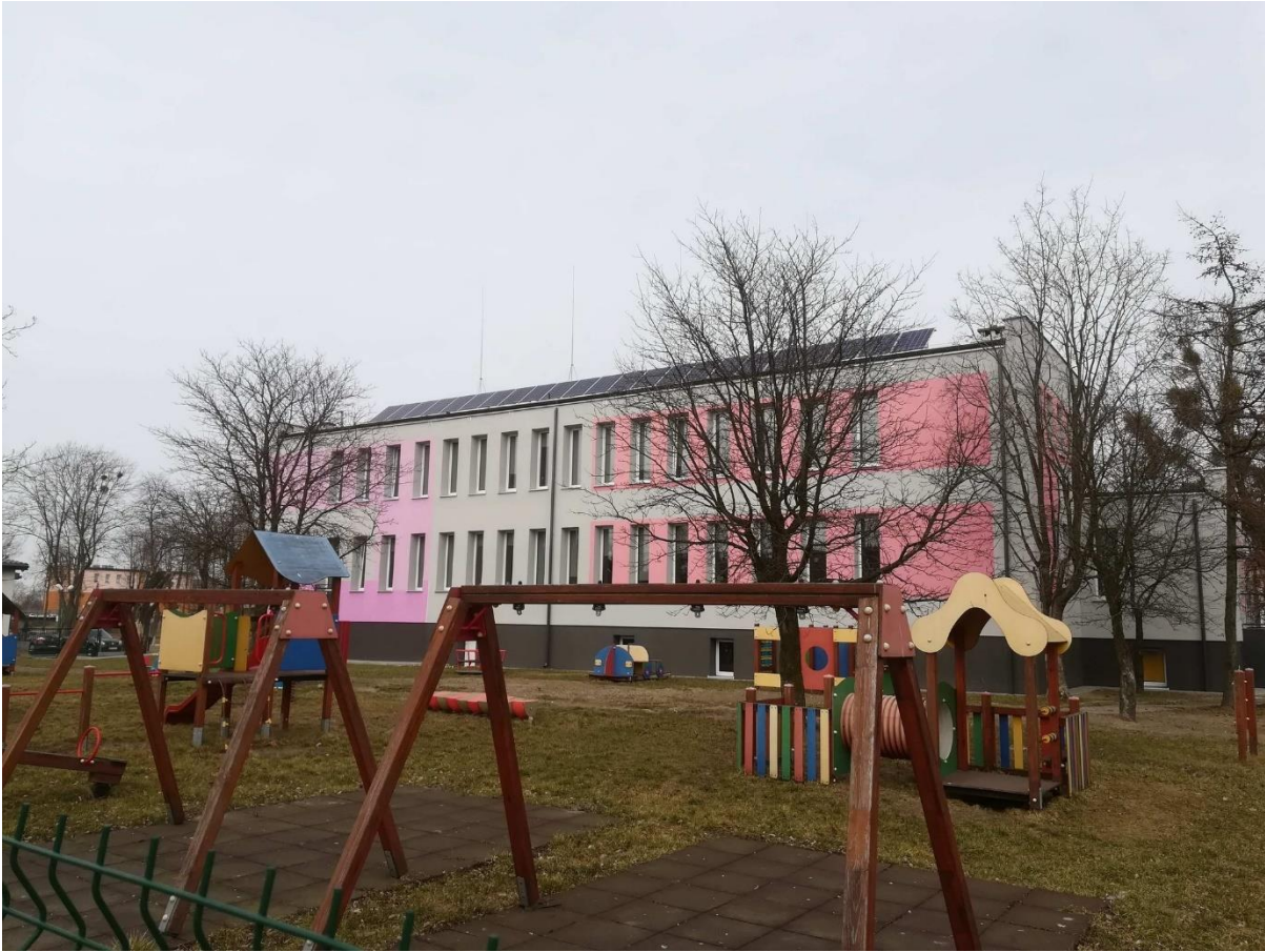
Budynek Miejskiego Przedszkola w Raciążu
