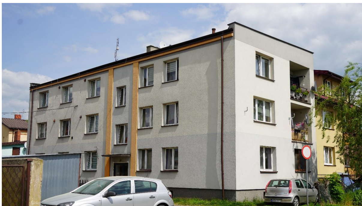
Budynek komunalny przy ul. Błonie 55
