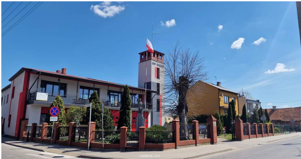
Termomodernizacja budynku Ochotniczej Straży Pożarnej w Raciążu przy ul. Kilińskiego 23
