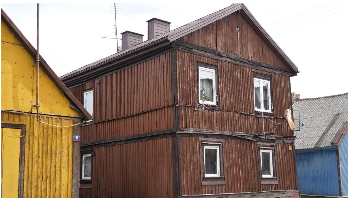
Budynek komunalny przy ul. Kilińskiego 11
