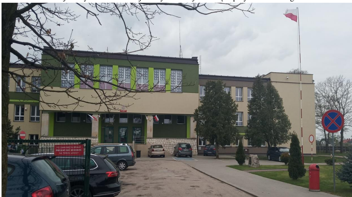
Termomodernizacja budynku Szkoły Podstawowej im. St. Konarskiego w Raciążu przy ul. Kilińskiego 62B
