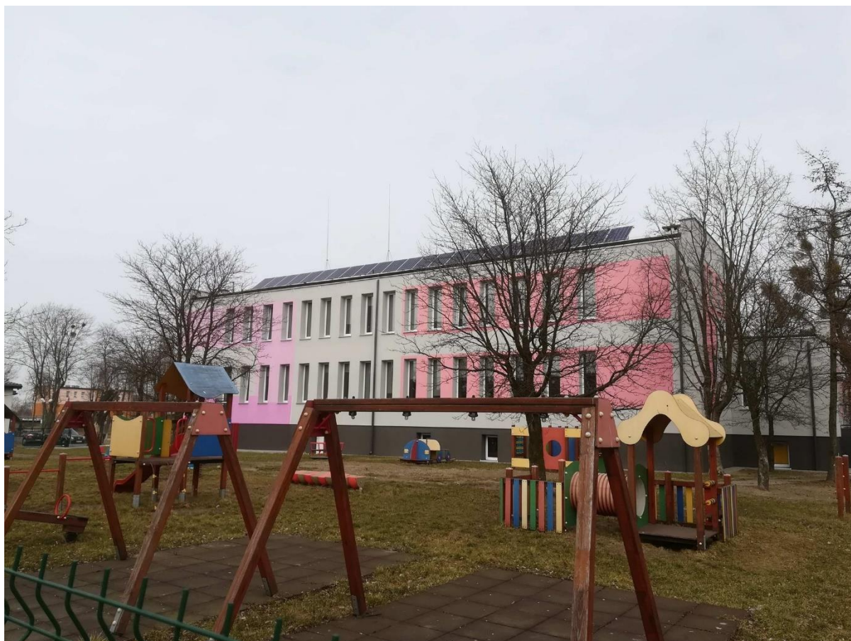
Budynek Miejskiego Przedszkola w Raciążu
